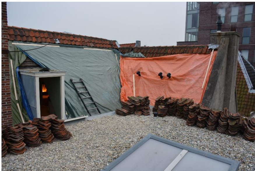
Het dak van het Nobelhuis tijdens de onderhoudswerkzaamheden
