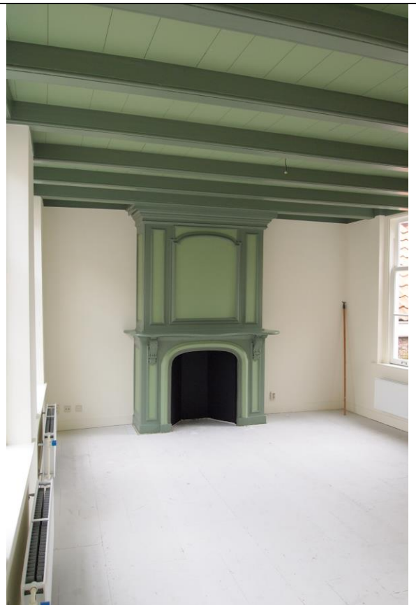
De gerestaureerde schouw en balklaag op de tweede verdieping.
